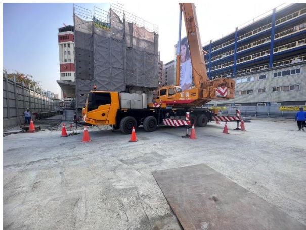
移動起重機作業半徑管制
